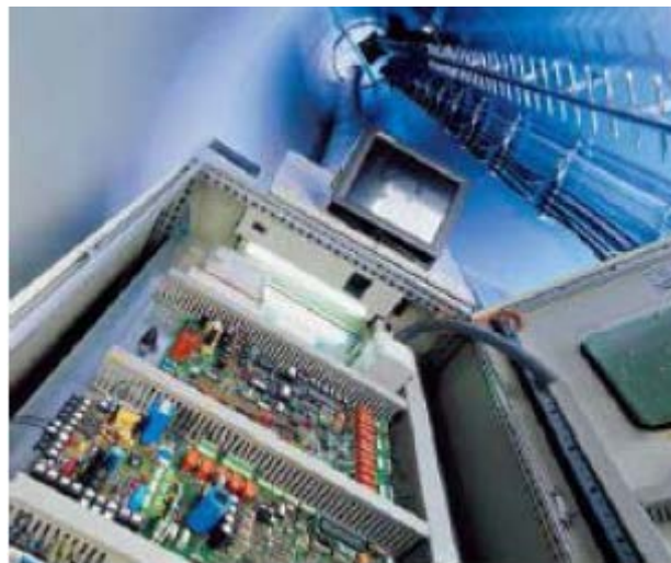
Contrôleur Enercon en pied de mât
