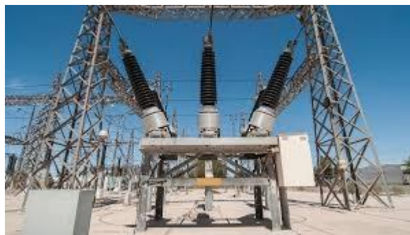
Figure III.6. Disjoncteur SF6
