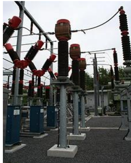
Figure III.2. Transformateur d'intensité.
