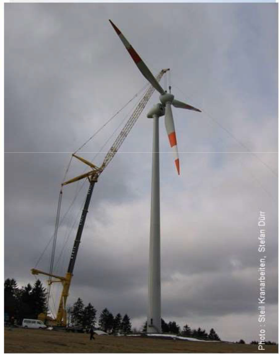
Photo : Steil Kranarbeiten, Stefan Dürr
